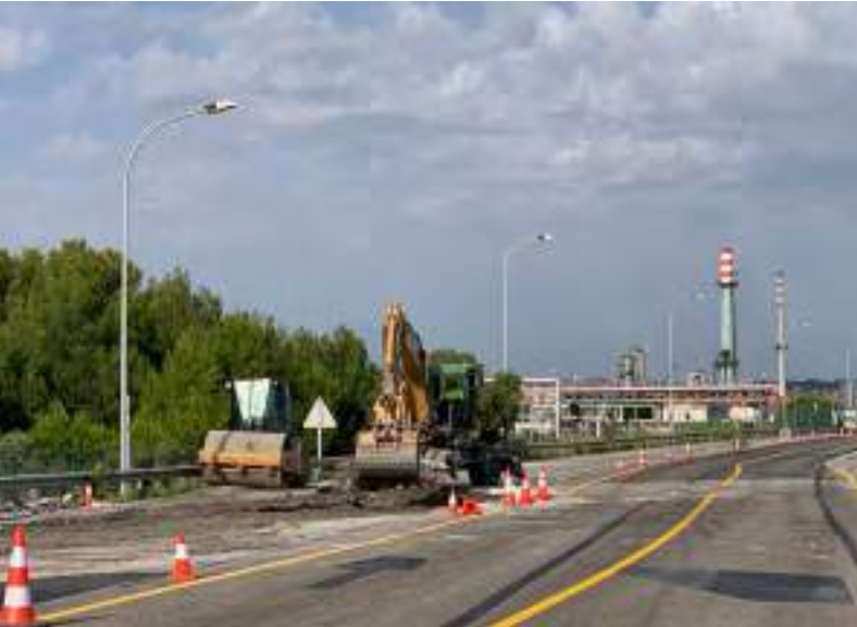
Obras de pavimentación en muelles Wharf surfacing work
